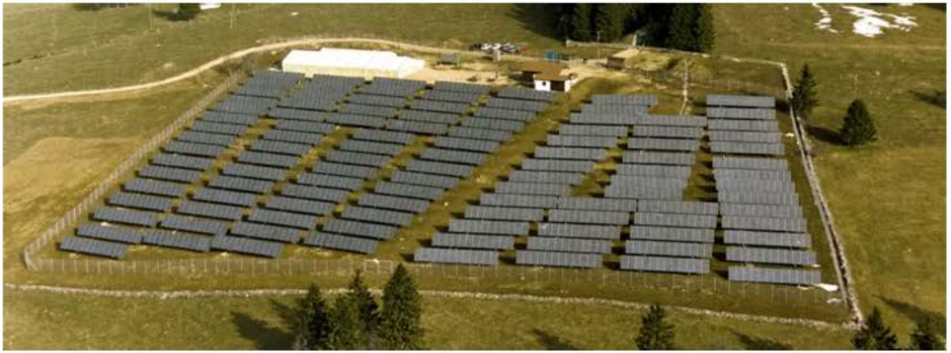
Luftaufnahme der Baustelle des Solarkraftwerks Mont Soleil im Berner Jura kurz vor der Einweihung und Inbetriebnahme, aufgenommen am 24. April 1992. - Keystone
