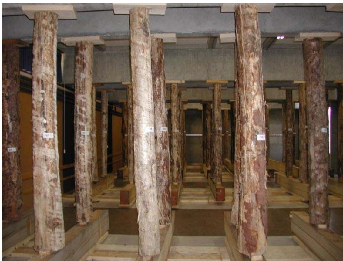
Puntelli di legno adottati quale misura d'urgenza per assicurare le travi portanti
