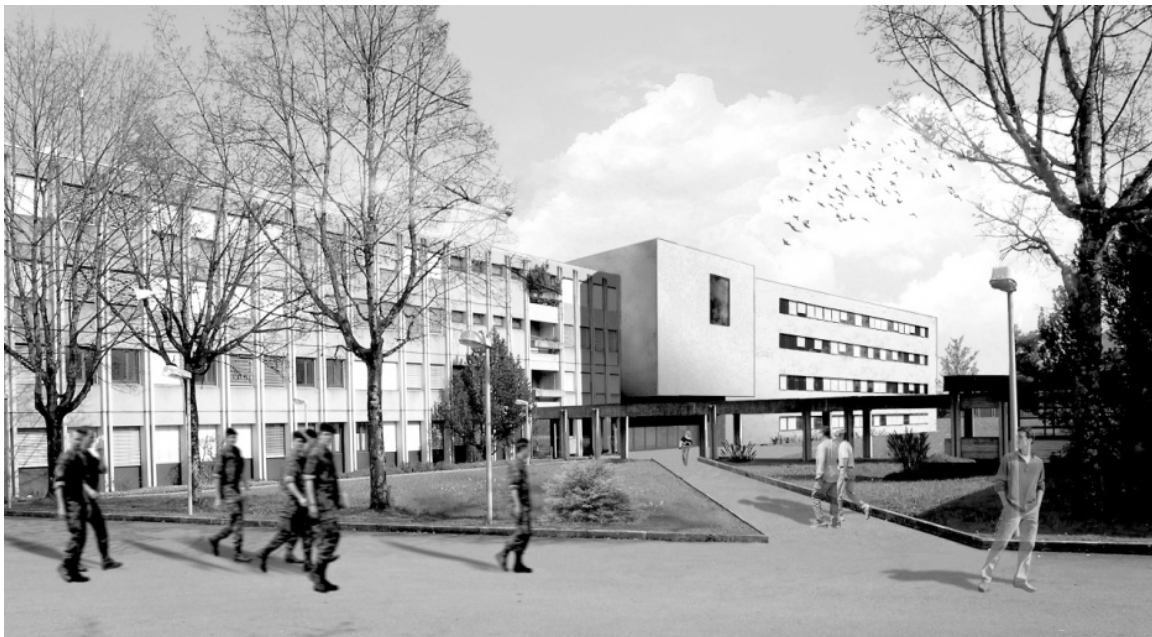
Edificio degli alloggi esistente con la nuova costruzione
