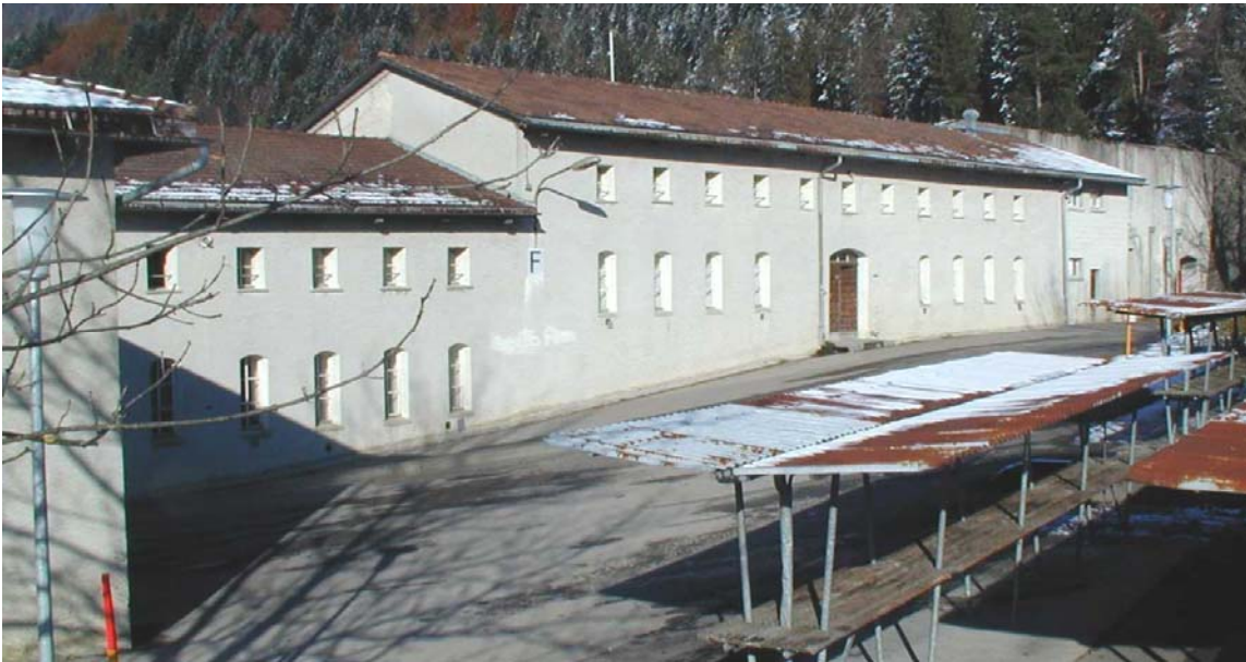
Vue de la façade sud-est du groupe de bâtiments sud Partie supérieure de l'ensemble de bâtiments avec avant-place au-dessus de la route cantonale (futurs cantonnements)
