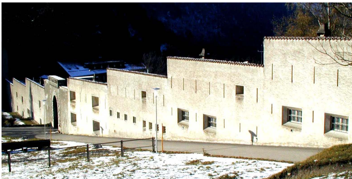
Vue de la façade sud-est du groupe de bâtiments sud Partie inférieure de l'ensemble de bâtiments situés au-dessus de la route cantonale (futurs cantonnements)
