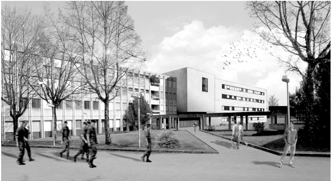
Bâtiment des cantonnements complété par la nouvelle construction (montage)
