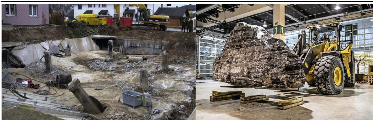
Effondrement du parking couvert de Gretzenbach en 2004 à la suite d'une surcharge (à gauche), Illustration d'une possible surcharge (à droite)
