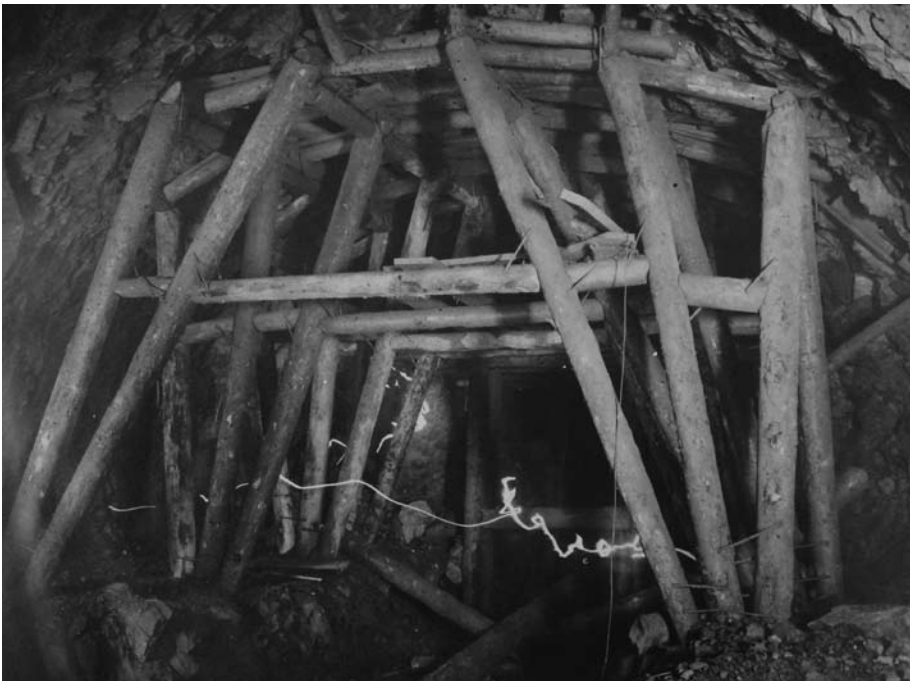
Stollen einer Radaranlage in Bau
