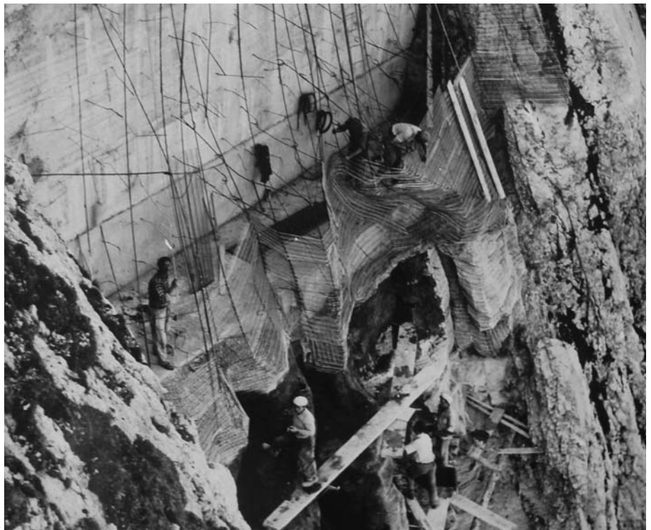
12 Tarnungsarbeiten an einer Antennenstellung im Hochgebirge
