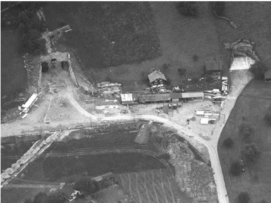
7 Flugzeugkaverne im Bau
