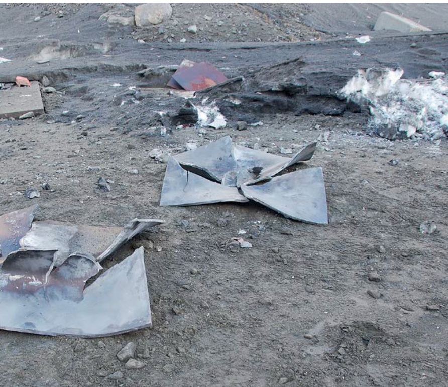
Nach der Sprengung zusammengetragene Plattenstücke. Sie lagen in einer maximalen Entfernung von 40 m. Durch die Wucht wurden die Betonquader, welche jeweils 600 kg wiegen, ca. 10 m verschoben.
