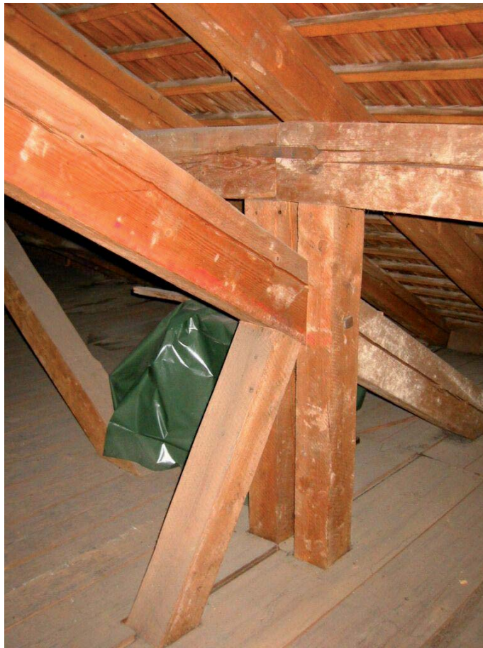
Zangenförmige Säule in der Dachkonstruktion
