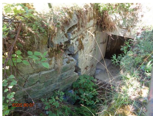
Figura 11: Durante un controllo, il 17 agosto 2023 è stato constatato un tentativo di irruzione presso il riparo di Disentis (GR). L'irruzione è avvenuta rompendo la saldatura della porta d'ingresso principale, che è liberamente accessibile e risulta poco visibile. Durante questo sopralluogo è stato inoltre notato che il muro di sostegno è estremamente pericolante a causa del degrado provocato dagli agenti atmosferici. (Fonte SIME DDPS, 2023).
