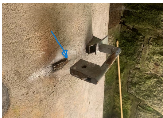
Figura 11: Durante un controllo, il 17 agosto 2023 è stato constatato un tentativo di irruzione presso il riparo di Disentis (GR). L'irruzione è avvenuta rompendo la saldatura della porta d'ingresso principale, che è liberamente accessibile e risulta poco visibile. Durante questo sopralluogo è stato inoltre notato che il muro di sostegno è estremamente pericolante a causa del degrado provocato dagli agenti atmosferici. (Fonte SIME DDPS, 2023).
