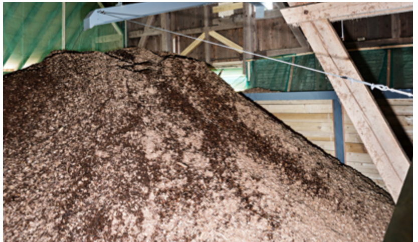
Die Holzsnitzel ragen vom Erdgeschoss bis ins Obergeschoss, wo sich die ehemaligen Knechtenkammern und darüber der Heuboden befanden.
