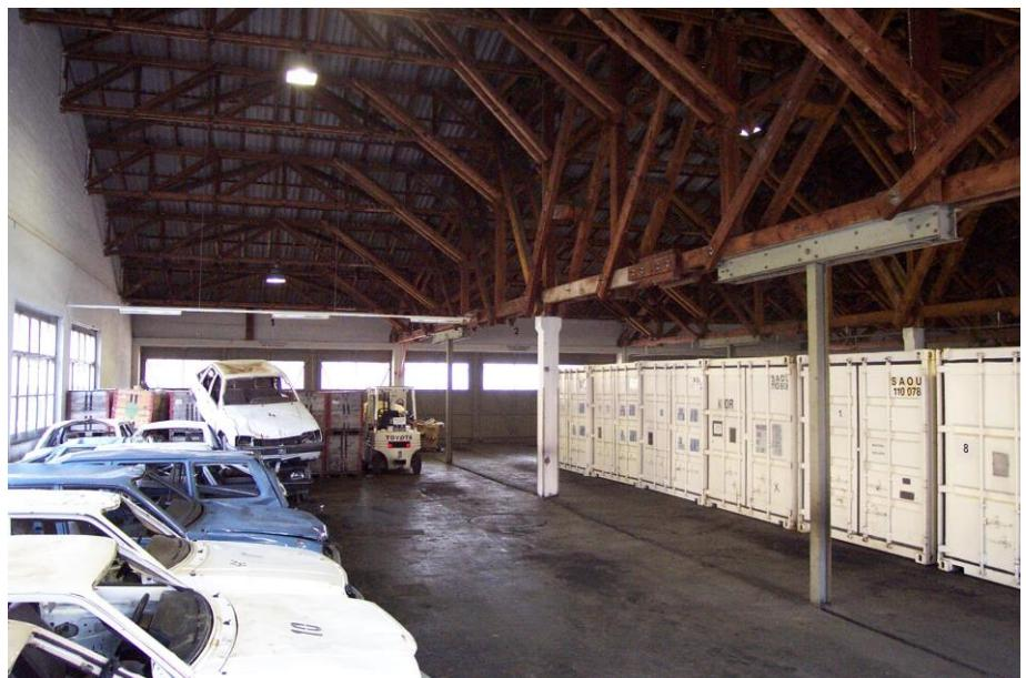
Detail der Fachwerkträger zur Windverstrebung. Rechts im Bild die Giebelwand W.
