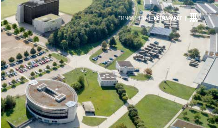
Die Abwärme des Rechenzentrums (oben links im Bild) strömt durch ein unterirdisches Verteilernetz zu sämtlichen Gebäuden des Waffenplatzes Frauenfeld.
