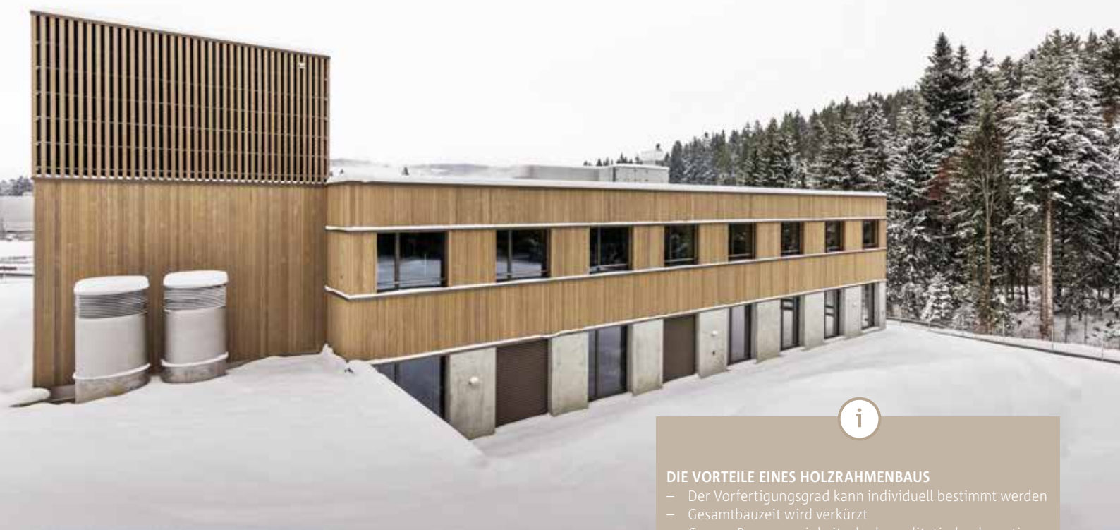
Der Bau ist vollendet – Aussenansicht der Kaserne Jassbach.
