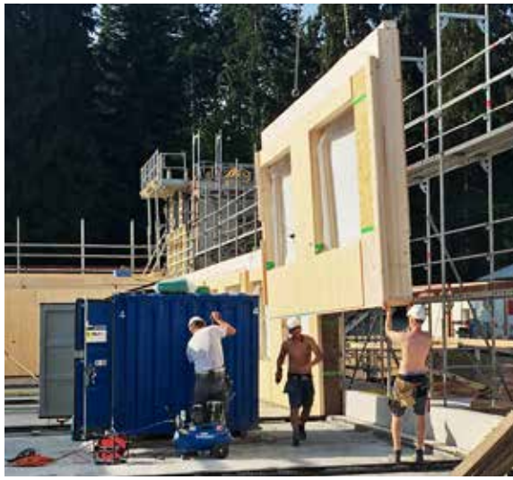
Die vorfabrizierten Rahmenelemente werden montiert.
