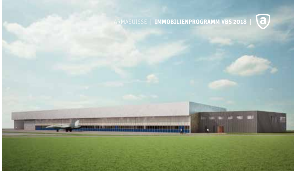
Flugplatz Payerne: Halle 4 nach Umbau und Erweiterung.
