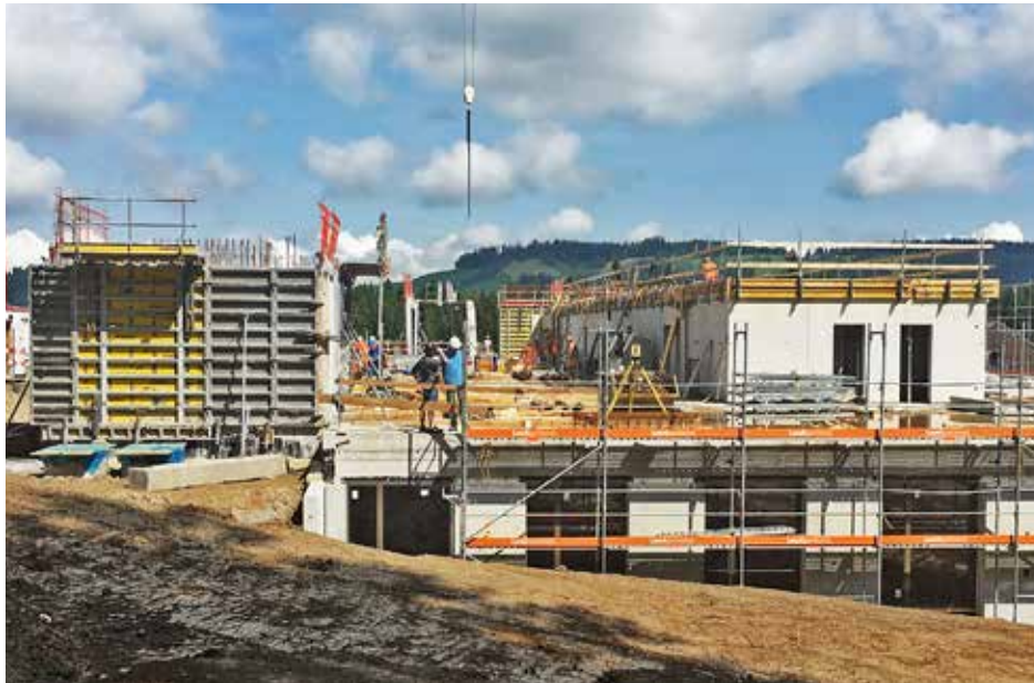
Die vorfabrizierten Rahmenelemente werden montiert.
