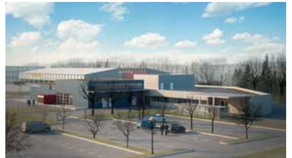
Waffenplatz Drogens: Verpflegungszentrum mit neuem Anbau.
