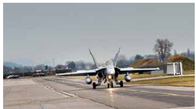
Flugplatz Payerne: Flugbetriebsflächen und Rollwege aus den 1950er-Jahren müssen saniert und an geltende Normen angepasst werden.
