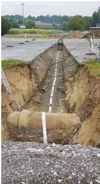
Schachtbauten und Verlegung der Kabelblöcke auf einer Länge von 2.1 km.
