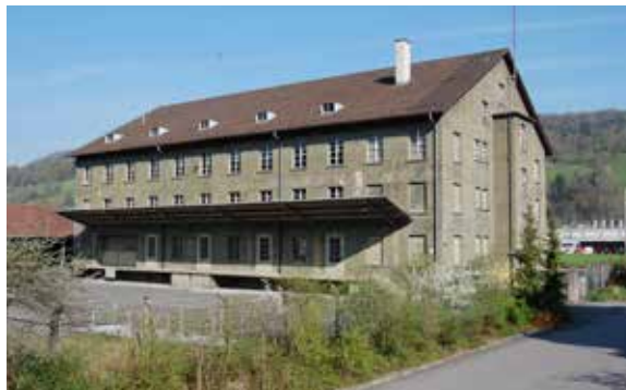
Ehemalige Militärinfrastrukturen eignen sich auch als zivile Lagergebäude, Zeughaus Malters LU.
