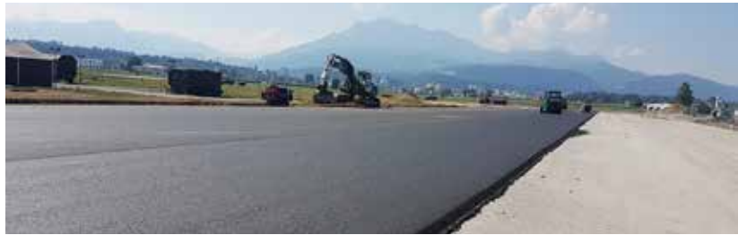
Neu befestigte Rollwege auf einer Fläche von 12 000 m 2 .
