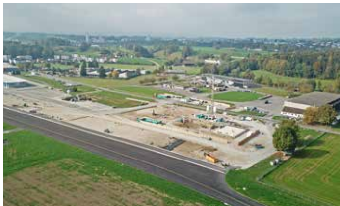
Das Vorhaben ist nach rund drei Monaten Vorbereitungsarbeiten bereit für den Rohbau.
