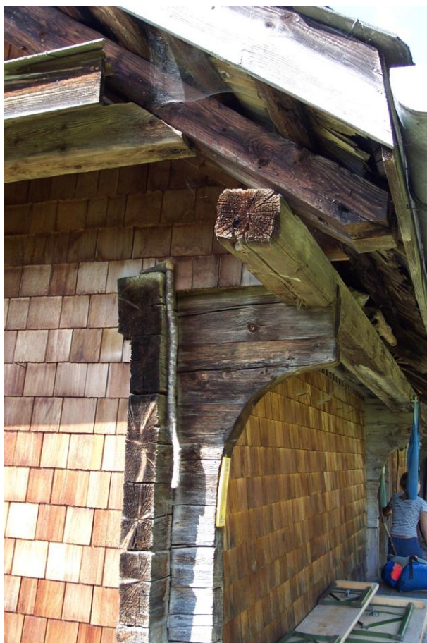
NO-Ecke, Detail: auf den konsolenartig auskragenden Blockvorstoss gelagerte Flugpfette der nördl. Traufseite
