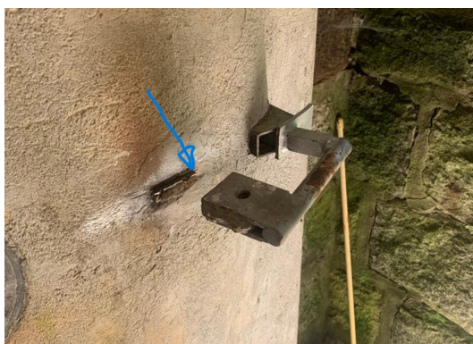
Abbildung 11: Beim Zugsunterstand Disentis GR, wurde anlässlich eines Kontrollgangs vom 17.08.2023 ein Einbruchversuch festgestellt. Der Einbruch erfolgte durch auftrennen der Verschweissung an der Haupteingangstür, welche frei zugänglich und nicht gut einsehbar ist. Ebenfalls erkannte man bei dieser Begehung, dass die Stützmauer durch Verwitterung stark einsturzgefährdet ist. (Quelle SIME VBS, 2023).
