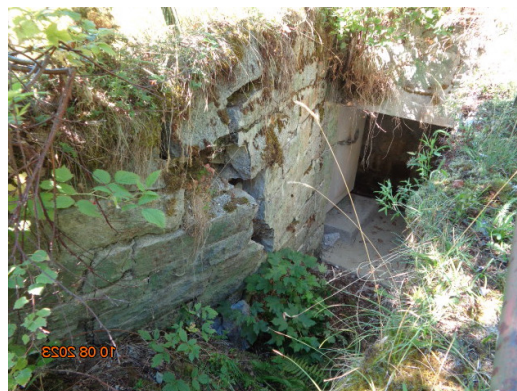
Abbildung 11: Beim Zugsunterstand Disentis GR, wurde anlässlich eines Kontrollgangs vom 17.08.2023 ein Einbruchversuch festgestellt. Der Einbruch erfolgte durch auftrennen der Verschweissung an der Haupteingangstür, welche frei zugänglich und nicht gut einsehbar ist. Ebenfalls erkannte man bei dieser Begehung, dass die Stützmauer durch Verwitterung stark einsturzgefährdet ist. (Quelle SIME VBS, 2023).
