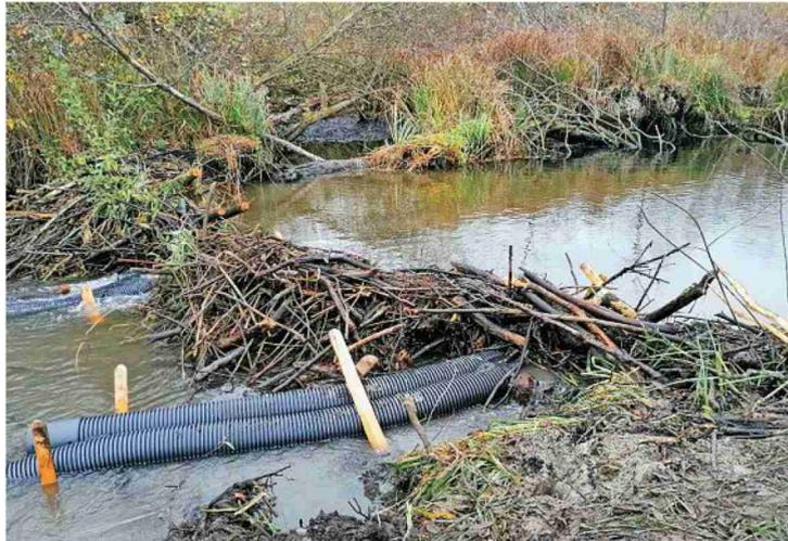
Eingriff an Nebendamm im Wahlenbach: Entlastungsrohre verbessern den Durchfluss und reduzieren Überschwemmungen. Foto: PD
