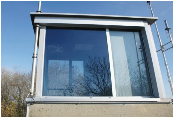
Bâtiment PC, place de tir de Forel
