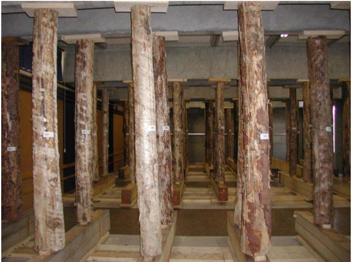
Holzpriessungen zur Sicherung der Hauptträger als Sofortmassnahme
