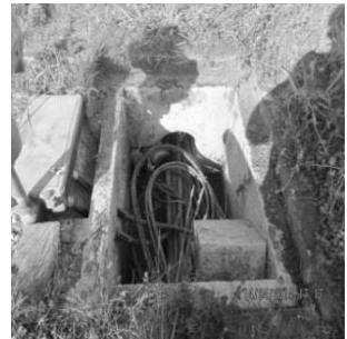
Erschliessungsschacht Strom
