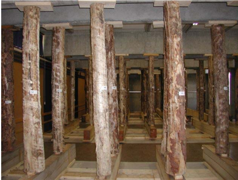
Holzspriessungen zur Sicherung der Hauptträger als Sofortmassnahme
