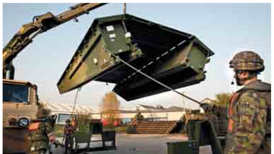
Brückenelement beim Zusammenfallen.
