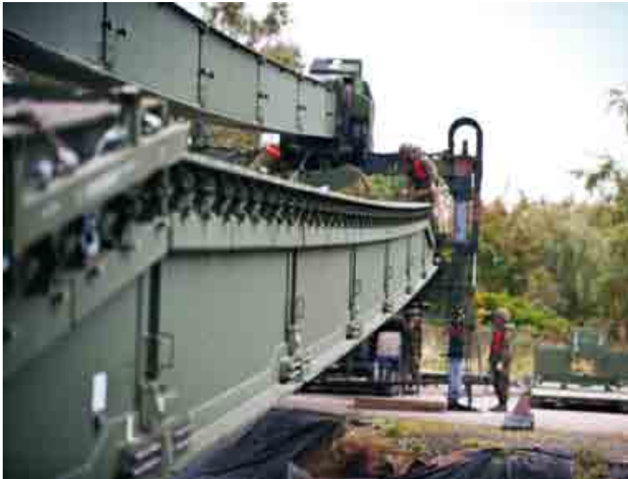
Brücke vor dem Absenken in die endgültige Position.
