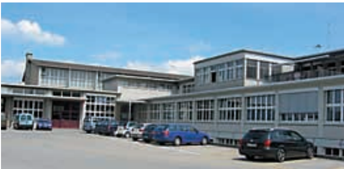
Hinwil (ZH), Logistik-Center Umgebung, Ausgestaltung des Logistik-Centers
