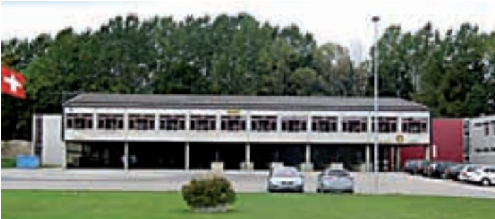
Drogens (FR), Waffenplatz Kaserne Sanierung und Umbau 2. Etappe
