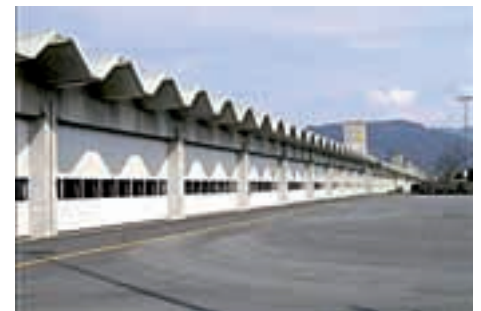
Thun (BE), Waffenplatz Ausbildungs- und Einstellhallen A bis P Sanierung Fassaden und Faltdächer
