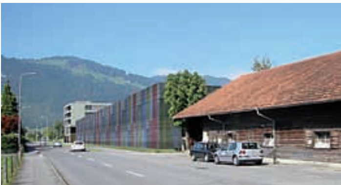
Wil bei Stans (NW), Waffenplatz Kompetenzzentrum SWISSINT Anpassung der Ausbildungs- und Einsatzinfrastruktur
