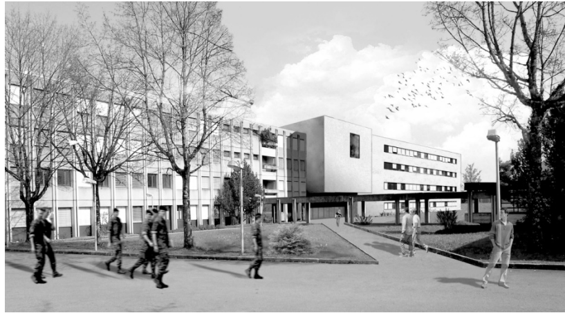
Bestehendes Unterkunftsgebäude mit Neubau
