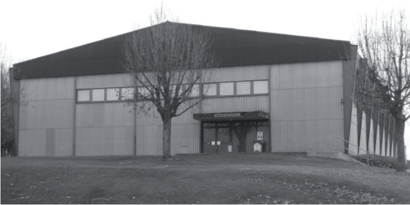
Ansicht bestehende Mehrzweckhalle
