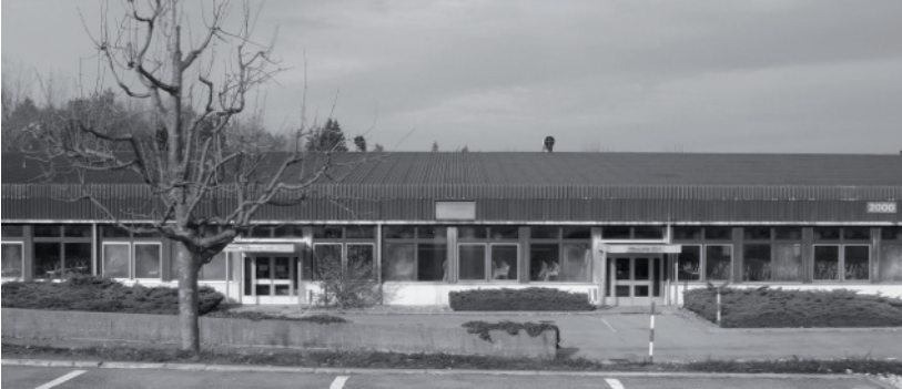
Ansicht Front bestehendes Gebäude.
