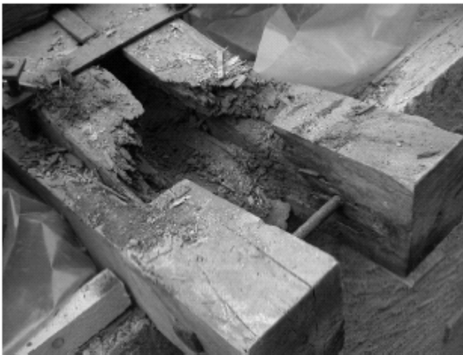
Holz-Zustand bei Knotenpunkten
